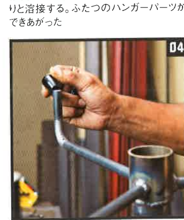
04 仕上げに脚先端にキャップをはめれば、ハンガーボールの完成だ
