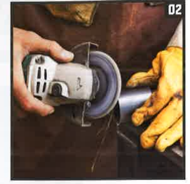
02 カットした材の切断面はディスクグラインダーで研磨し、バリを取っておく
