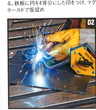
02 それぞれのアタッチメント4方向にフックを溶接する
