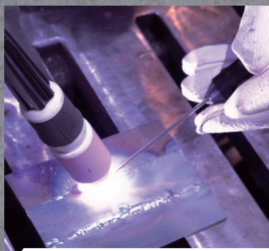
高精度の溶接作業を実現
